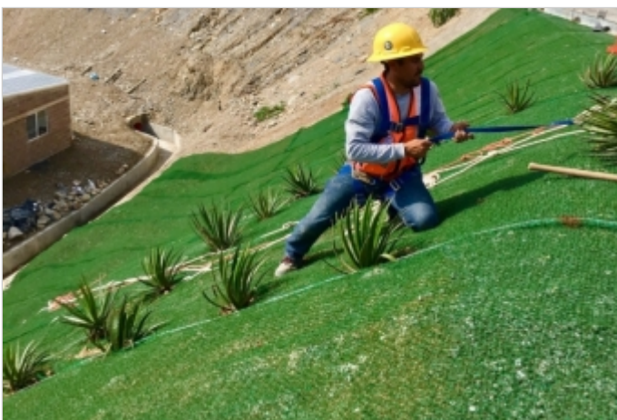
Durante la Obra
