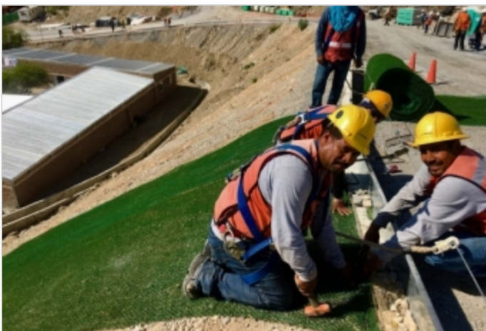
Durante la Obra
