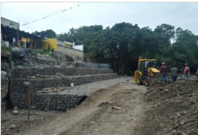
Durante la Obra
