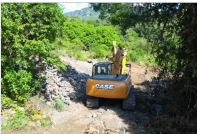
Durante la Obra
