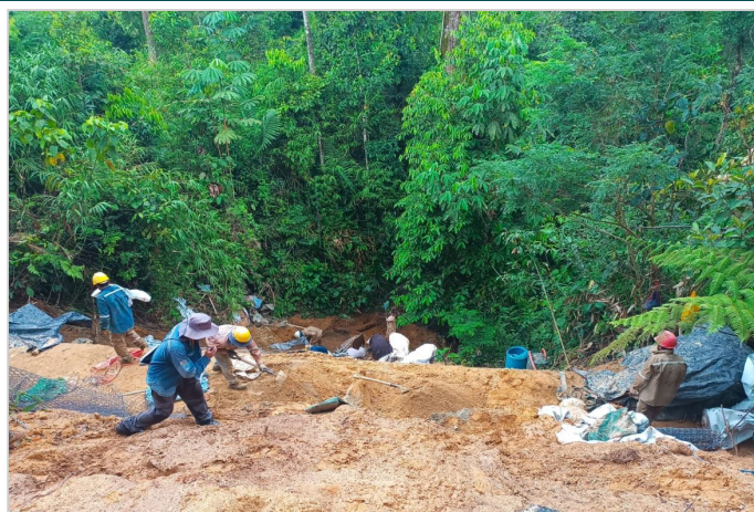
Durante la Obra
