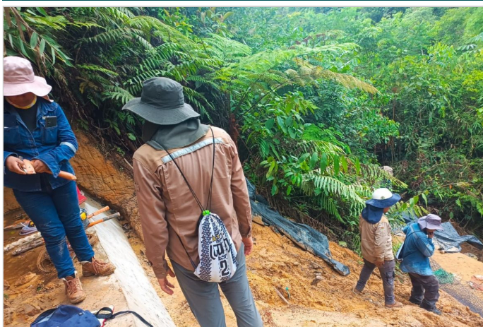
Durante la Obra
