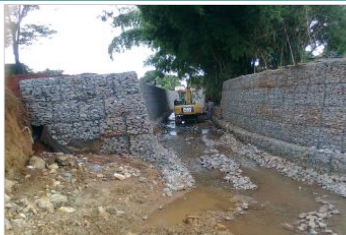
Durante a obra
