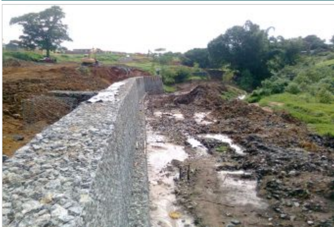
Durante a obra
