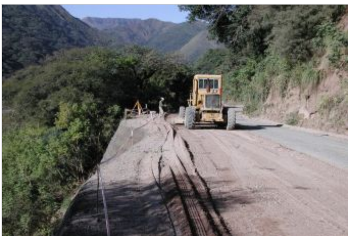
Durante la Obra
