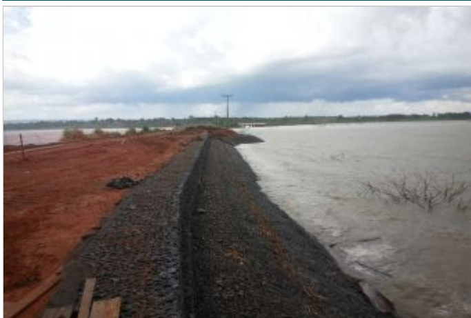
Durante la Obra
