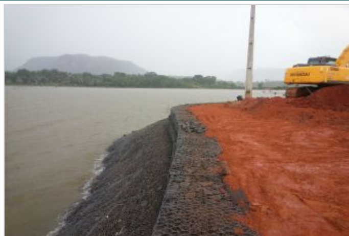
Durante la Obra
