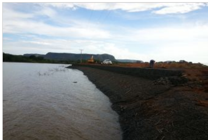
Durante la Obra
