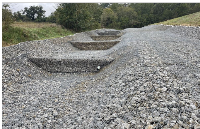
Déversoir en seuil de 1m de hauteur en gabions
