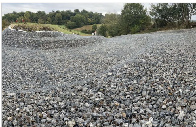
Lit majeur du coursier
