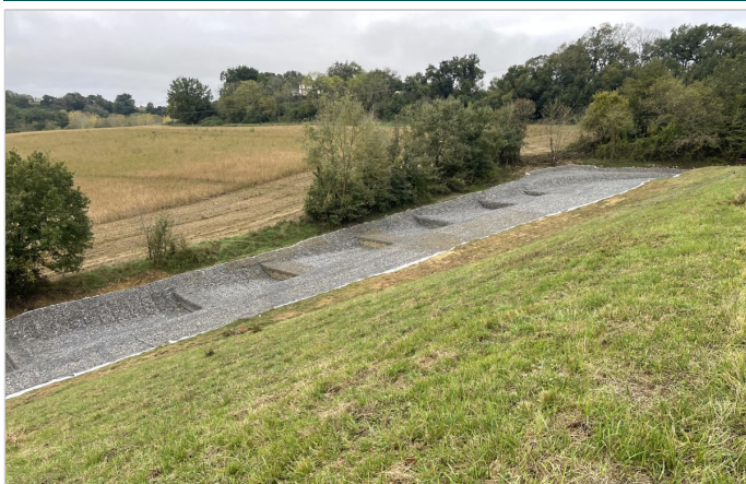
Vue du déversoir
