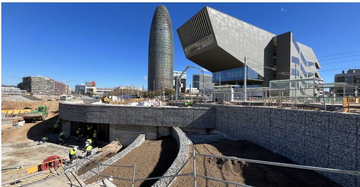
Proyecto en ejecución
