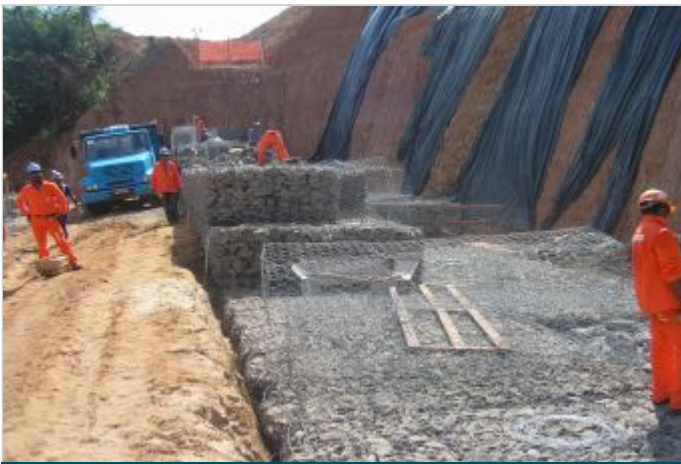
Durante a obra
