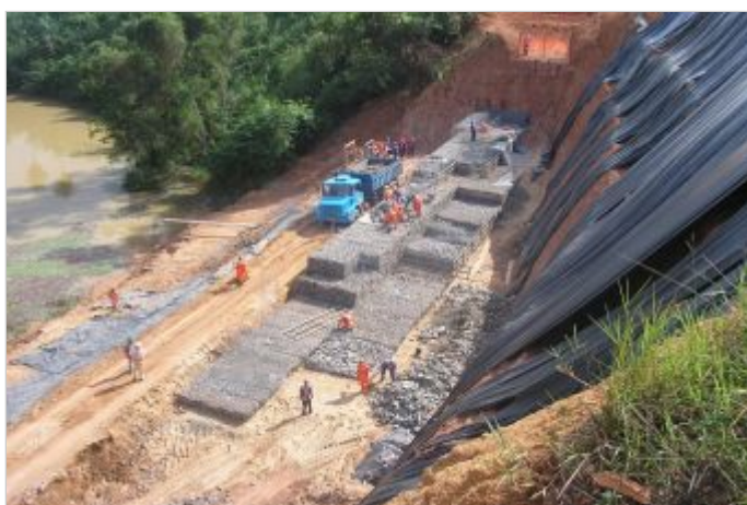
Durante a obra
