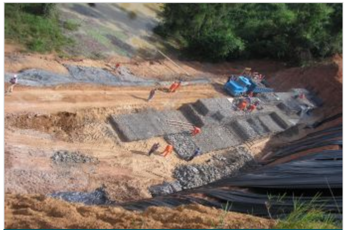
Durante a obra
