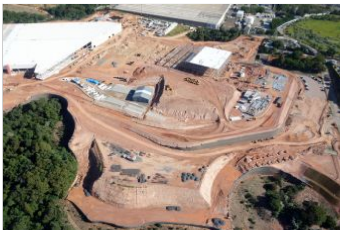
Durante a obra
