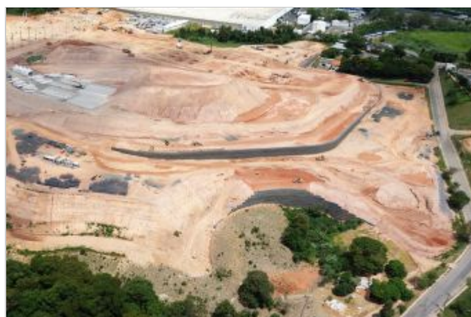
Durante a obra
