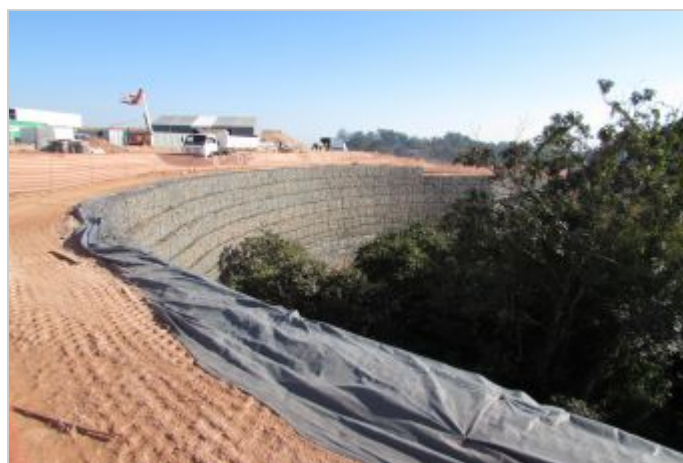
Durante a obra
