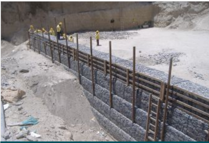
Durante a obra
