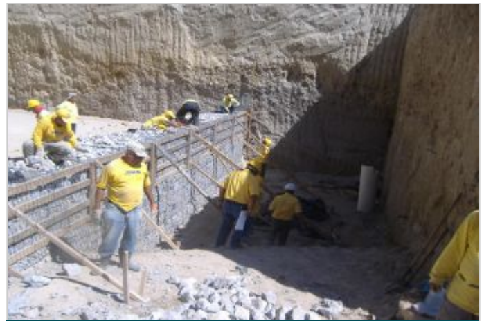
Durante a obra
