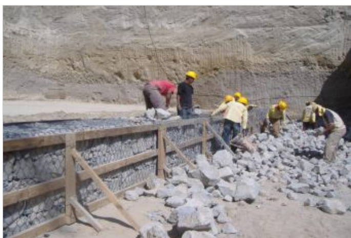
Durante a obra
