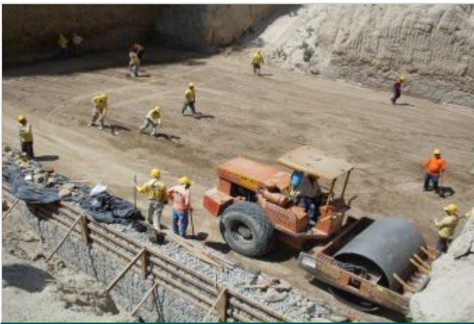
Durante a obra
