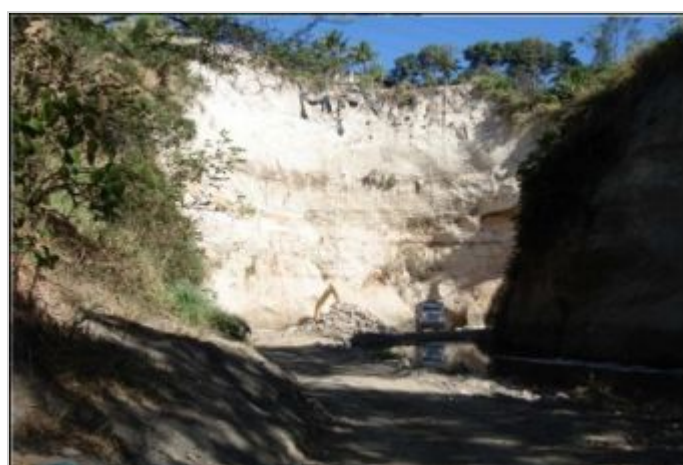
Durante a obra
