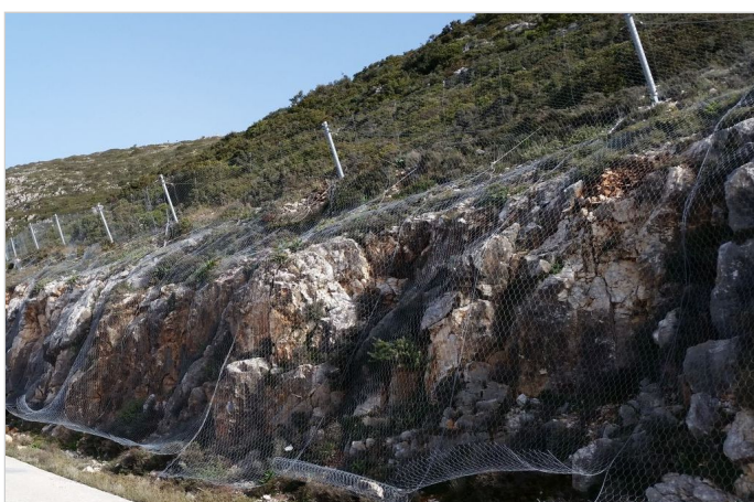
Τοποθέτηση φράκτη RMC050A & πλέγματος STEELGRID MO300
