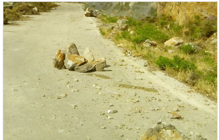
Βραχοπτώσεις κατά τη διάρκεια τοποθέτησης
