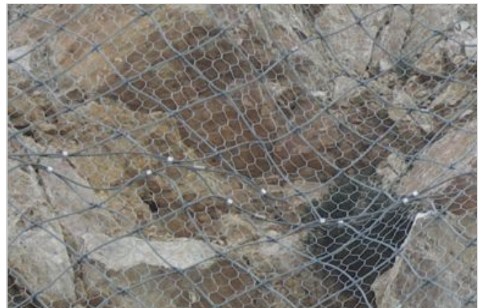
HEA PANEL, τοποθετημένο
