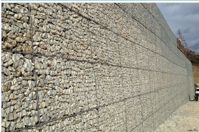
Pendant les travaux
