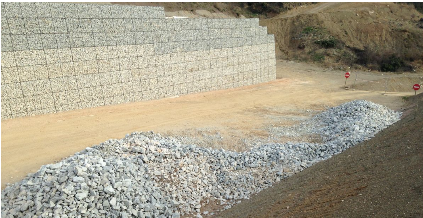
Travaux touchant à leur fin
