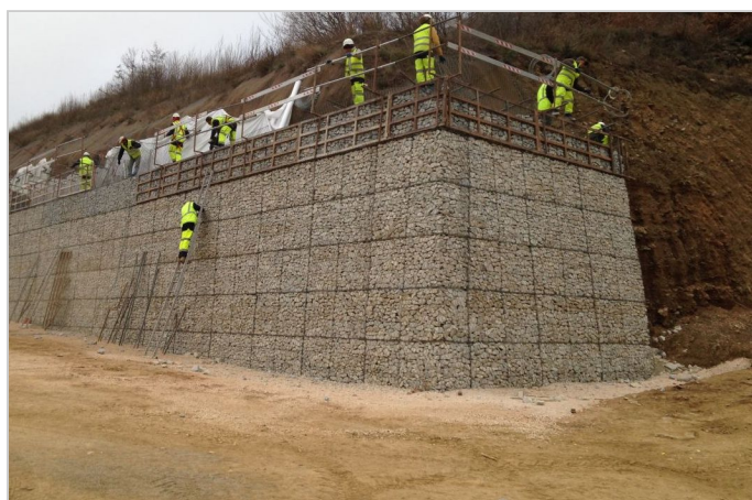
Pendant la mise en œuvre des gabions cloués
