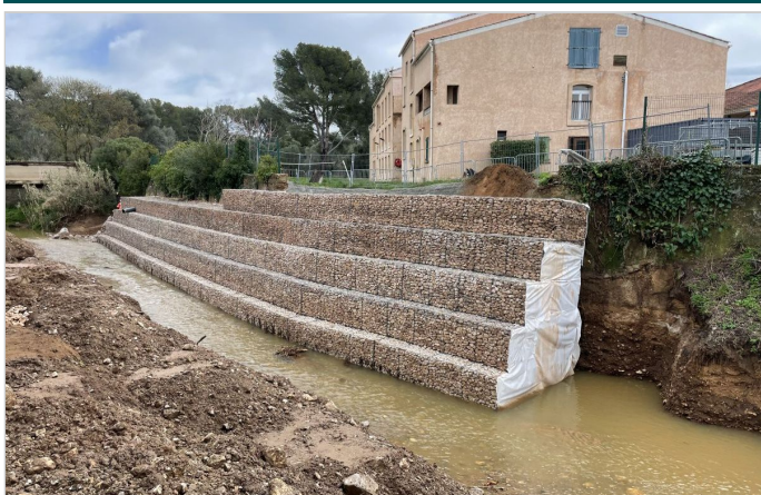
Ouvrage de soutènement en mur poids gabions
