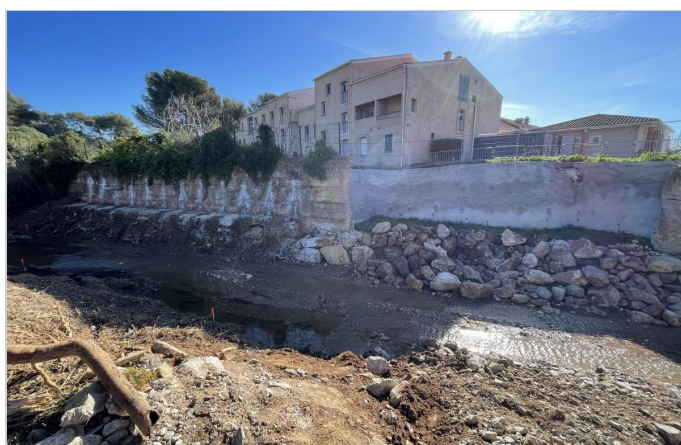
Avant les travaux
