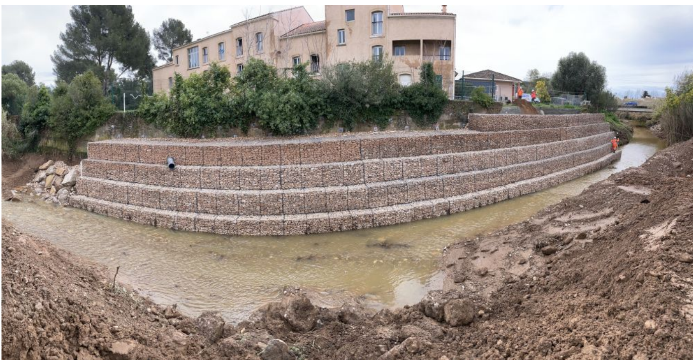
Vue d'ensemble de l'ouvrage
