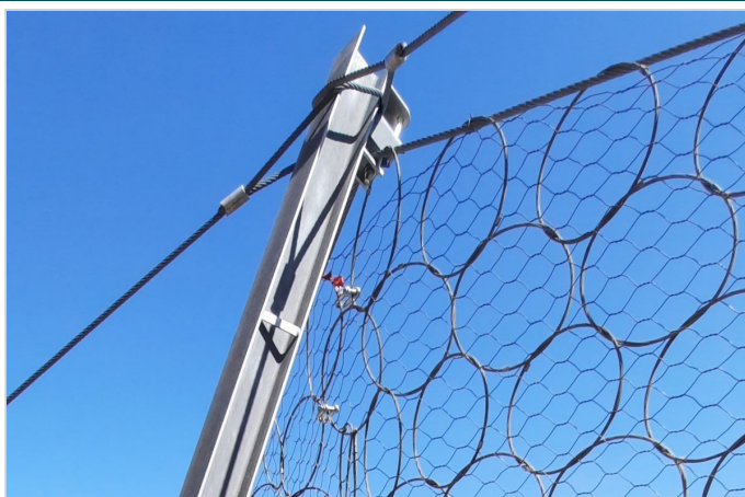
Detalle poste y membrana de interceptación
