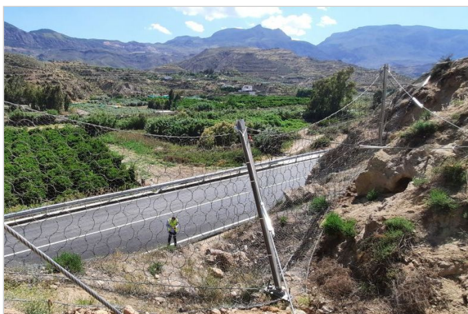
Vista barrera desde el lado monte
