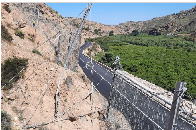
Vista tramos de la barrera
