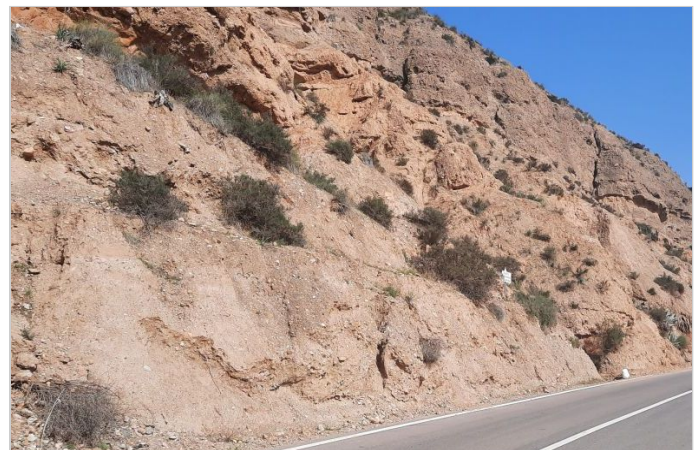
Vista del talud
