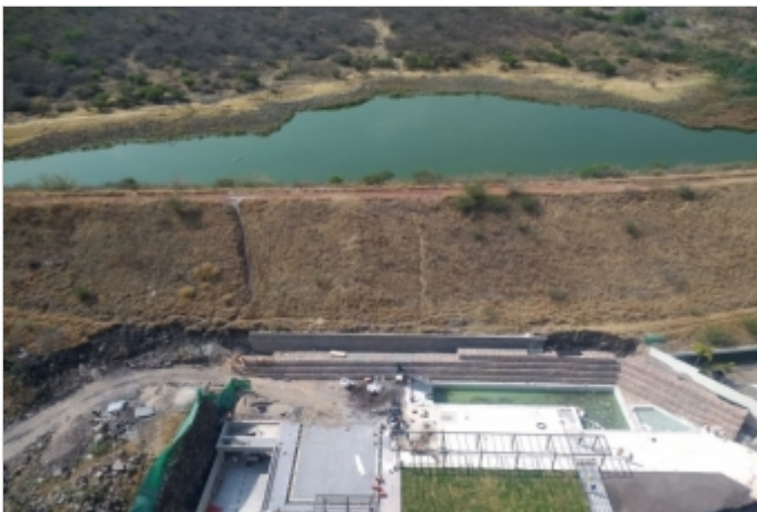
Durante la Obra
