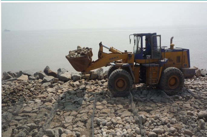
采用一般机械施工， 进一步提高施工效率
