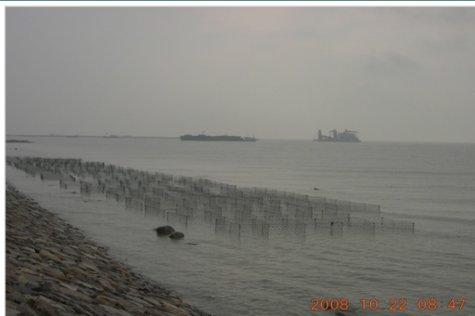
施工中， 涨潮时
