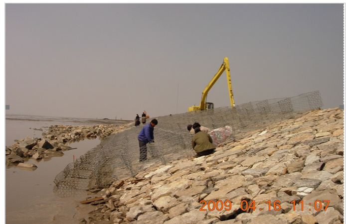
工地现场组装，人工绞合
