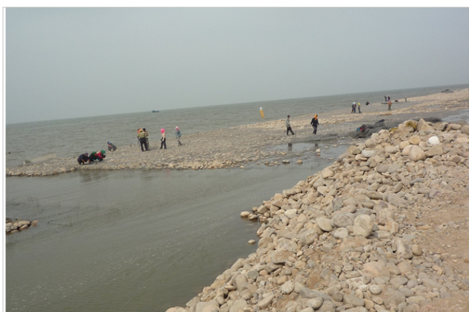
退潮后， 继续施工
