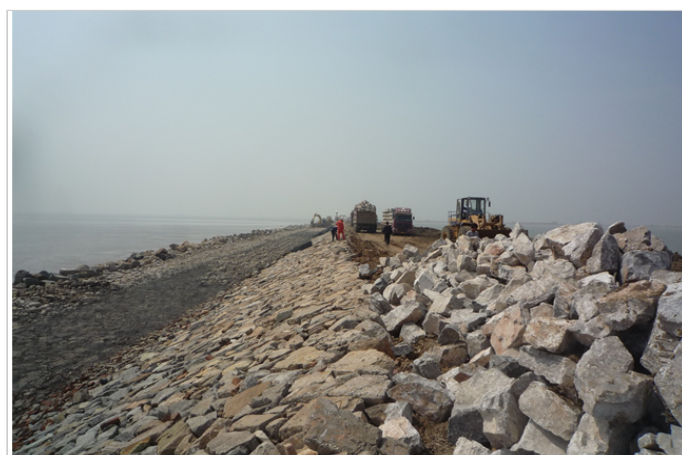
砌石理坡， 铺设格宾垫
