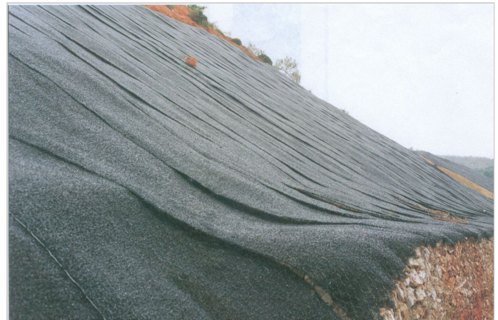
ΤΡΙΣΔΙΑΣΤΑΤΟ ΓΕΩΠΛΕΓΜΑ ΕΠΕΝΔΥΣΗΣ ΠΡΑΝΩΝ MACMAT 8.1 ΣΤΗ ΦΑΣΗ ΤΗΣ ΤΟΠΟΘΕΤΗΣΗΣ
