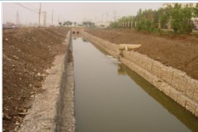
施工完半个月
