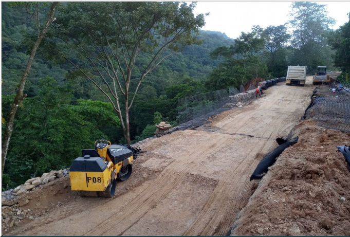
Durante la Obra
