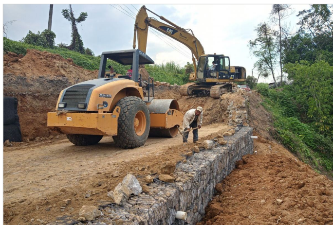
Durante la Obra
