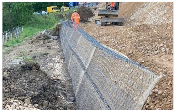
Travaux année 2022 - mise en place du TerraMesh Vert
