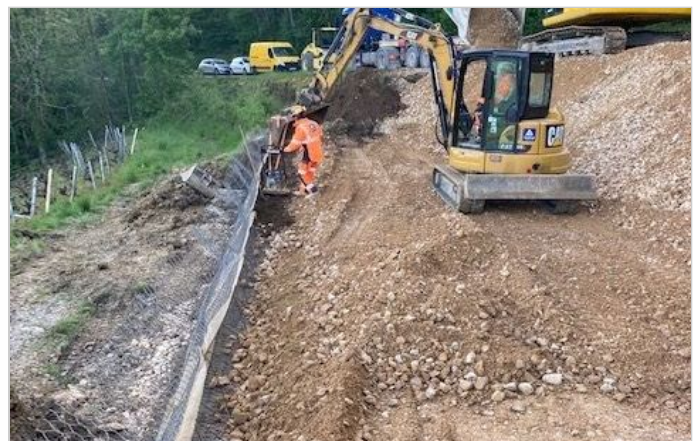
Mise en œuvre du TerraMesh vert (travaux année 2022)
