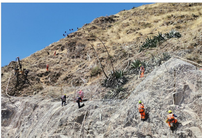
Durante la Obra
