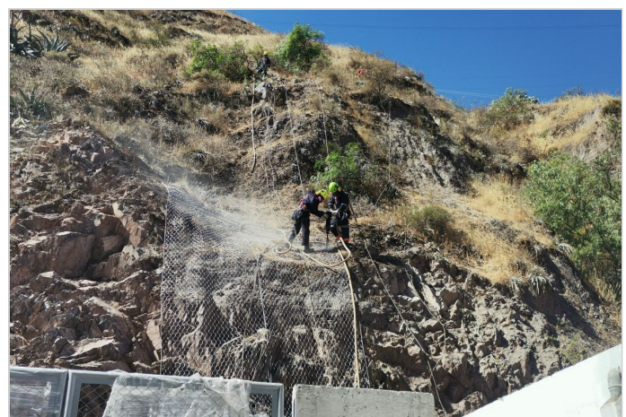
Durante la Obra
