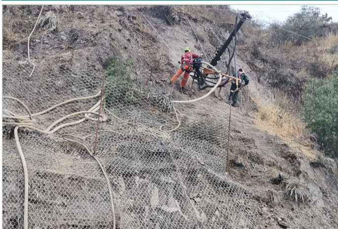
Durante la Obra
