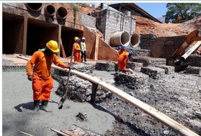
Durante a obra
