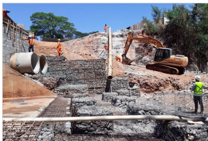
Durante a obra
