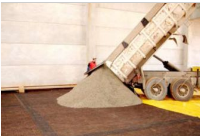
Durante a obra
