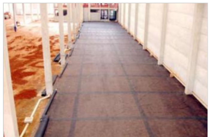
Durante a obra
