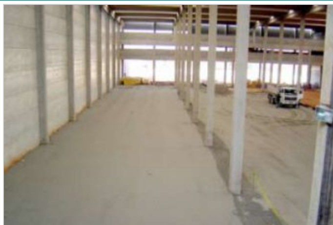
Durante a obra
