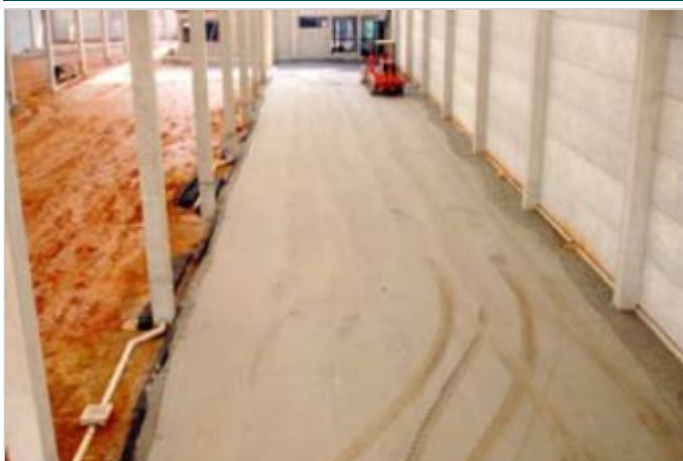
Durante a obra
