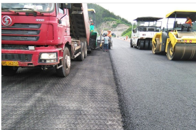
沥青摊铺II
