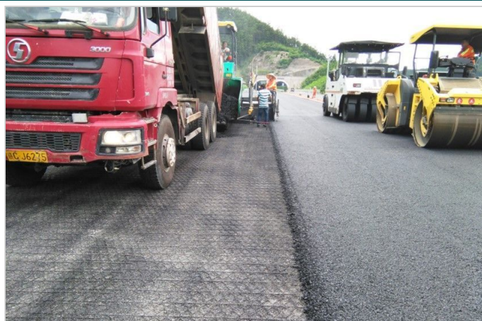
沥青摊铺II
