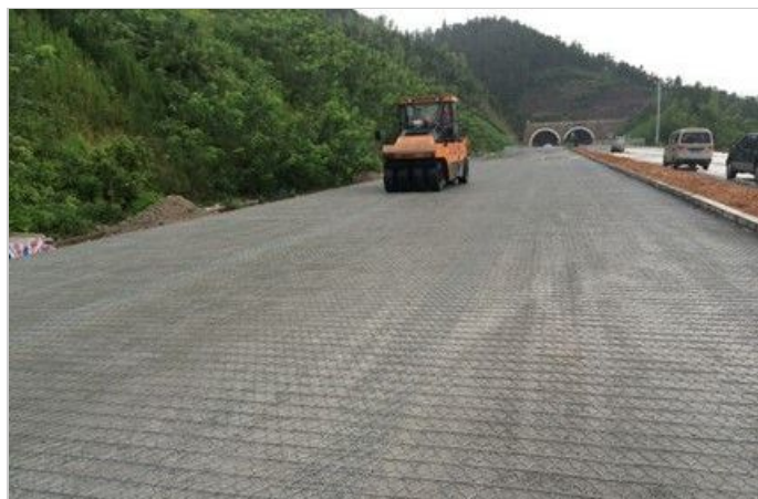
网面铺设施工
