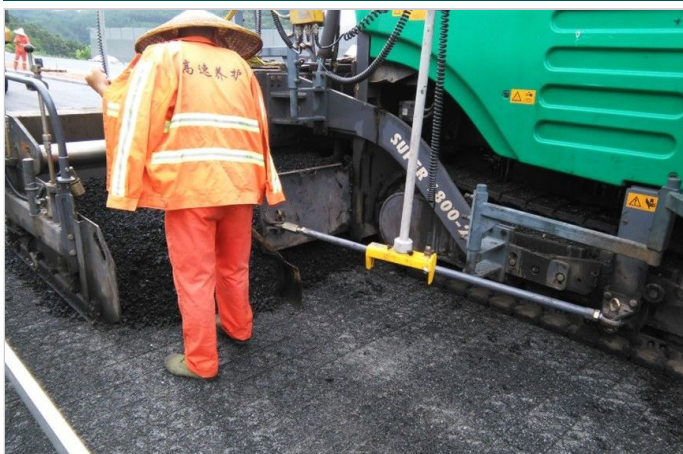
沥青摊铺I
