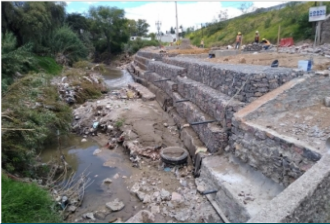
Durante la Obra
