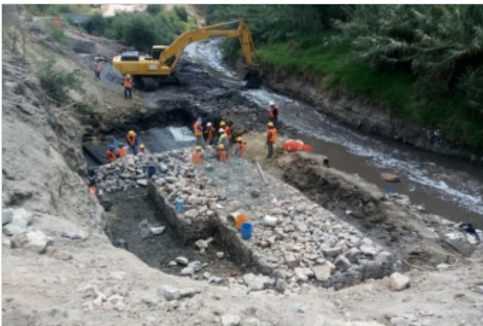
Durante la Obra
