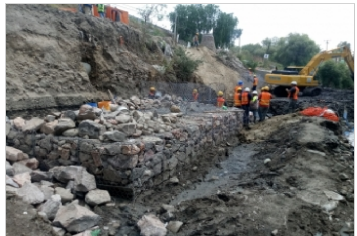
Durante la Obra
