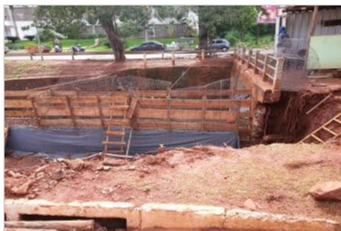
Durante la Obra
