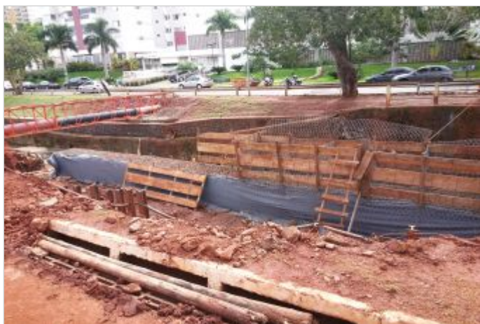
Durante la Obra
