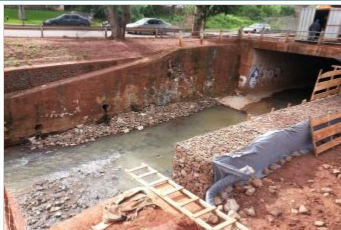
Durante la Obra
