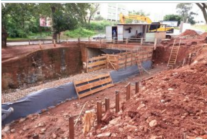
Durante la Obra
