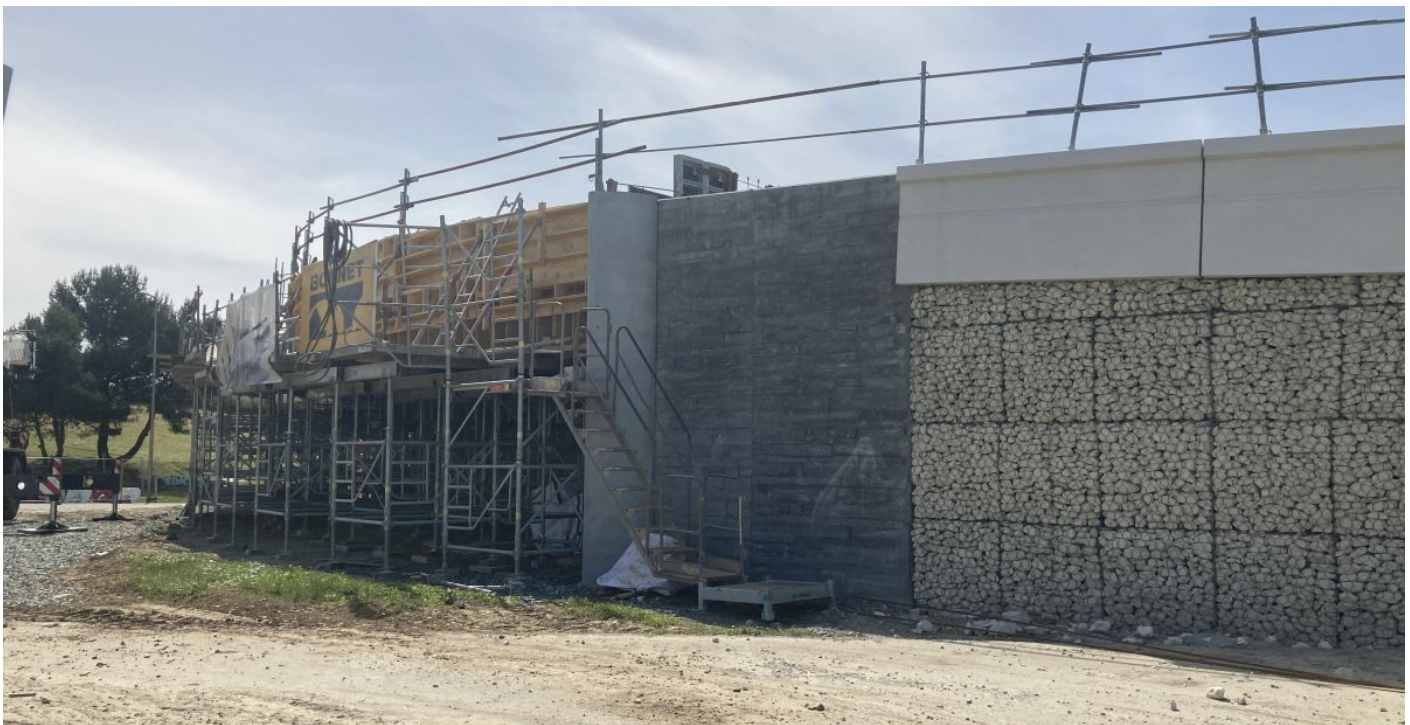
Mur en Terramesh System
