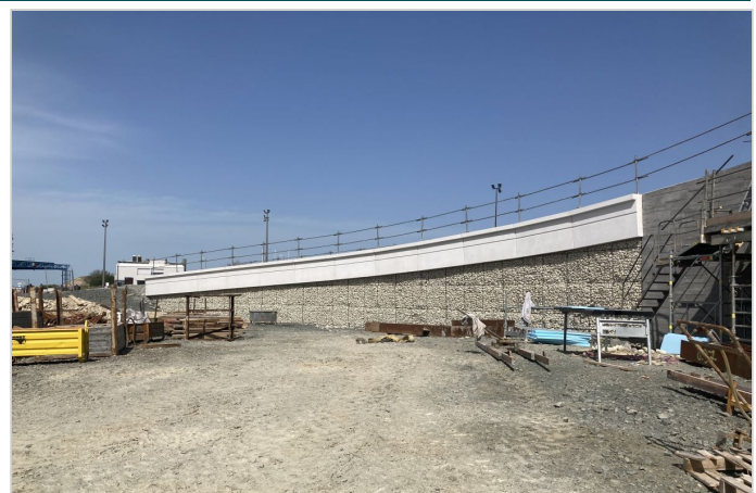
Mur en Terramesh System
