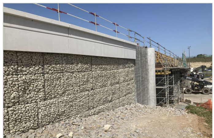
Mur en Terramesh System
