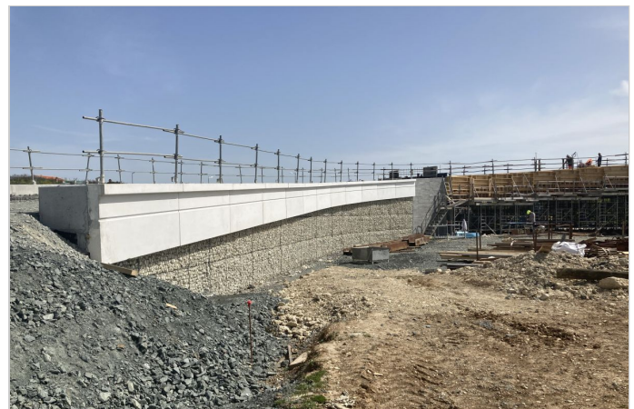
Mur en Terramesh System
