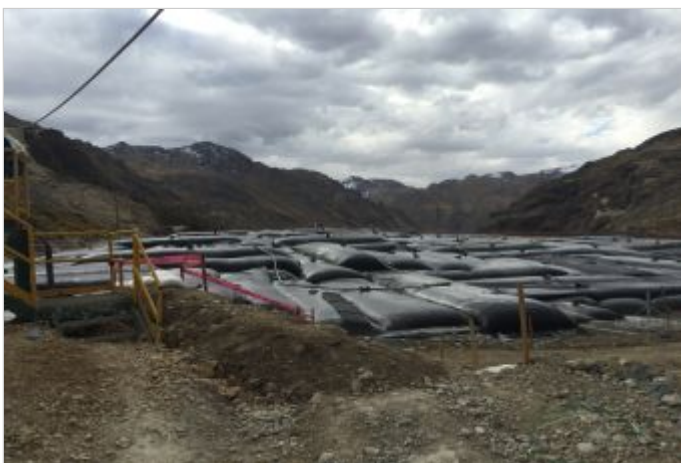
Durante a obra
