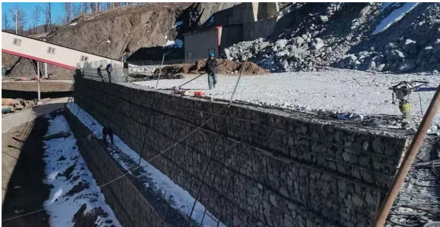
加筋格宾施工
