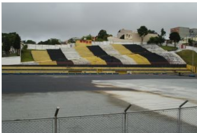
Durante la Obra
