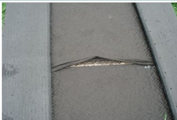
Durante la Obra
