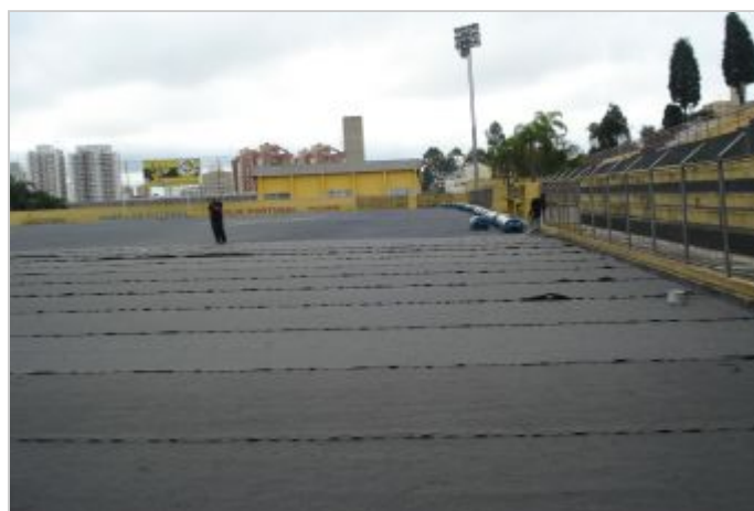
Durante la Obra
