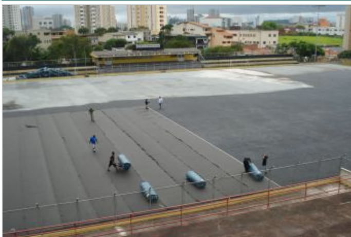
Durante la Obra
