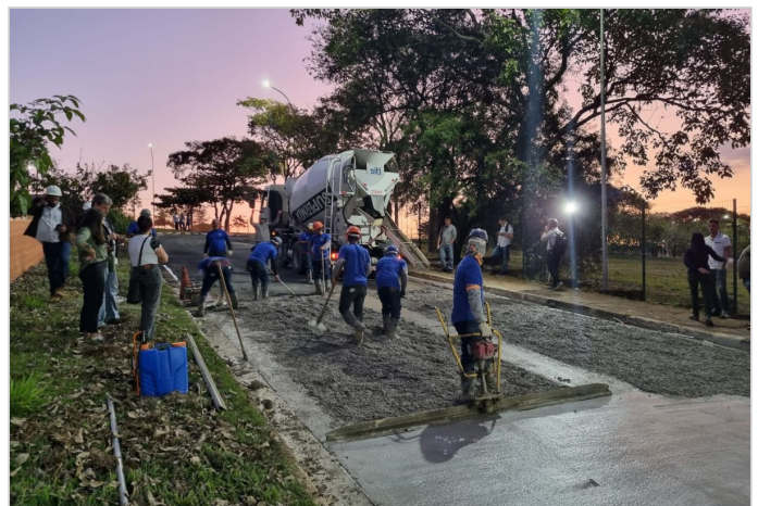
Durante a obra
