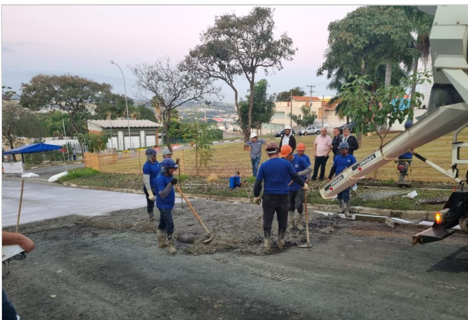
Durante a obra
