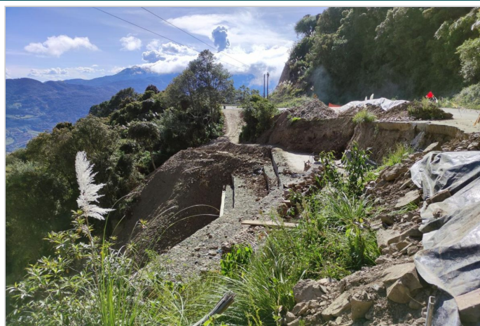
Durante la Obra
