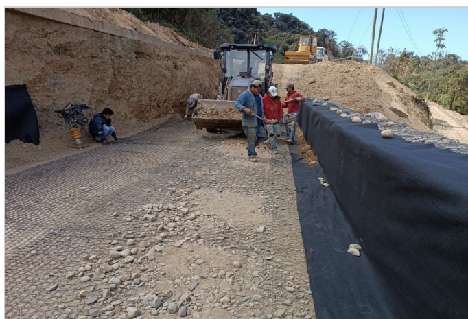
Durante la Obra
