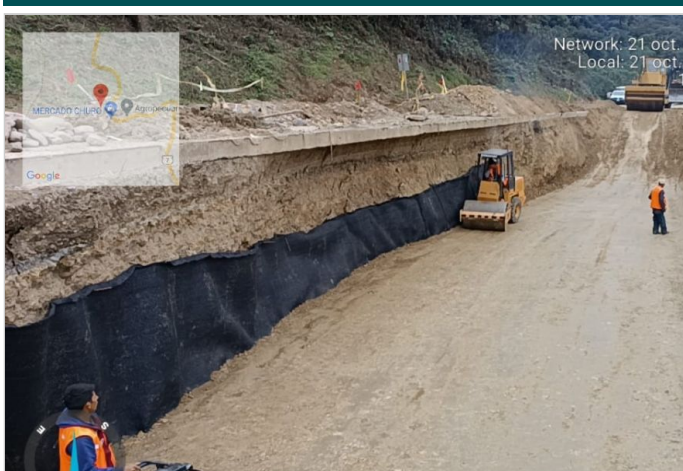
Durante la Obra
