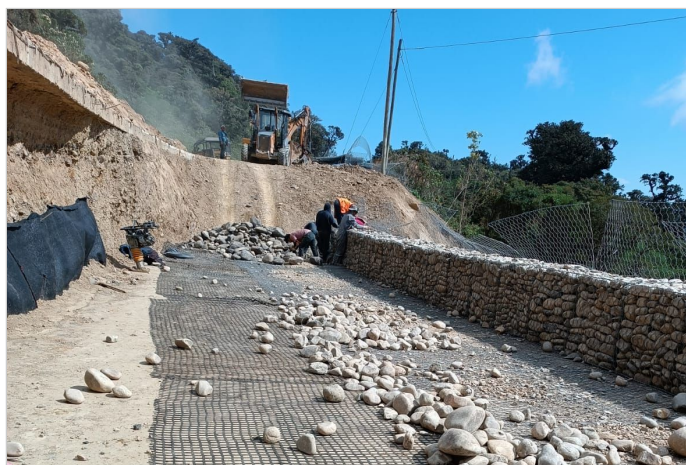
Durante la Obra
