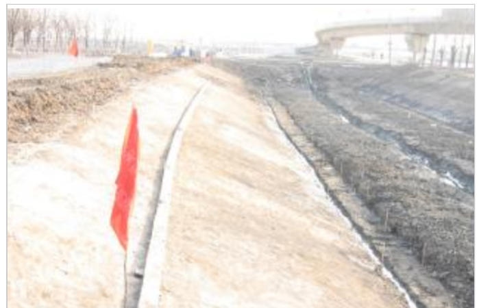
施工前边坡平整
