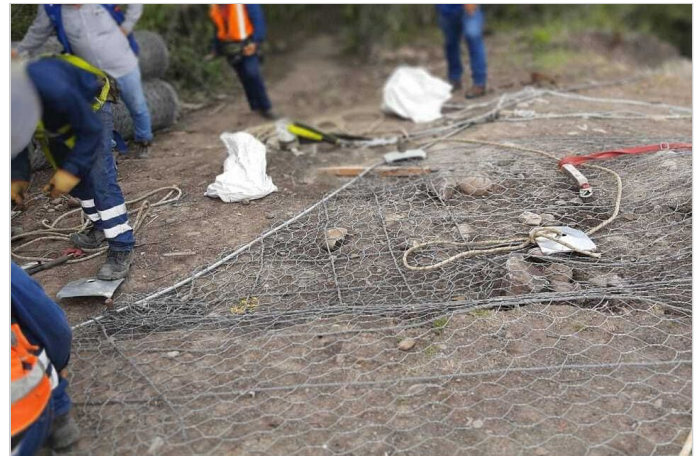
Durante la Obra
