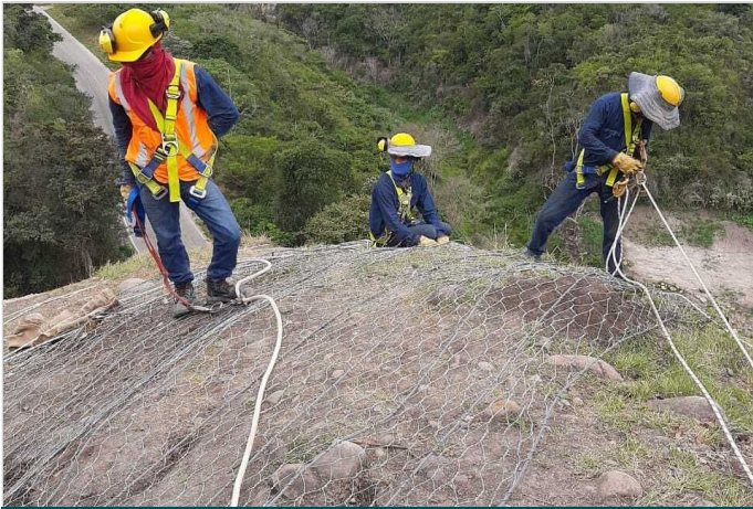
Durante la Obra
