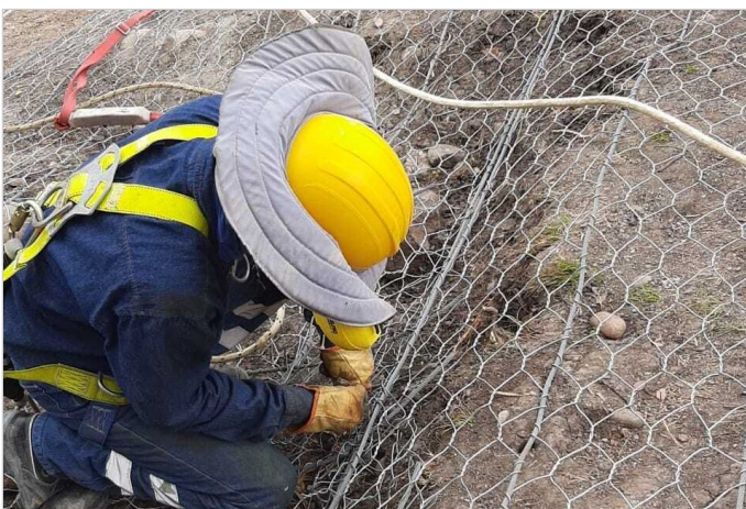
Durante la Obra
