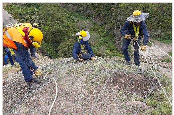
Durante la Obra
