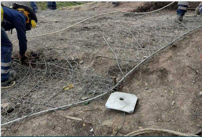
Durante la Obra
