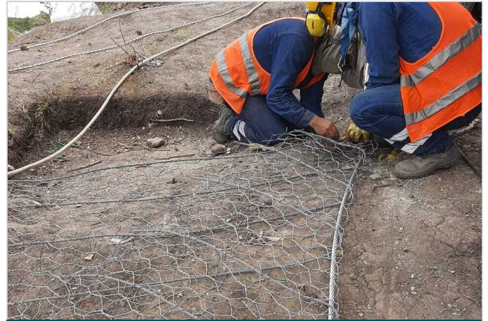
Durante la Obra
