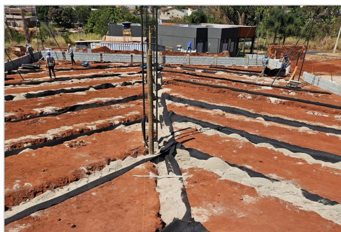
Durante a obra
