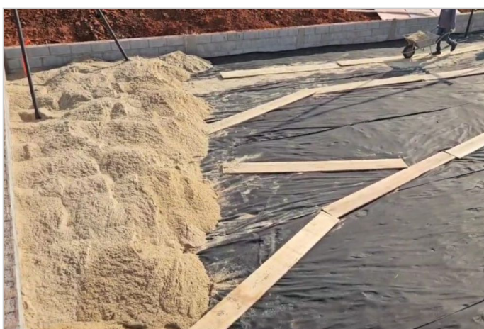
Durante a obra
