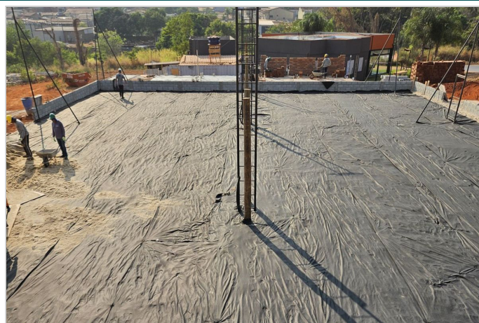
Durante a obra
