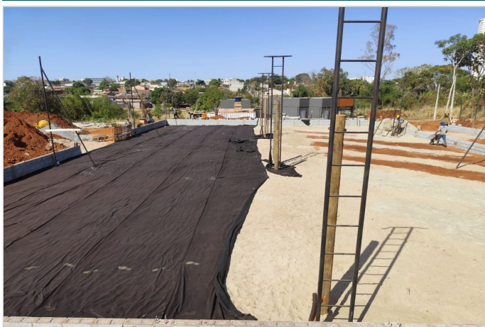
Durante a obra
