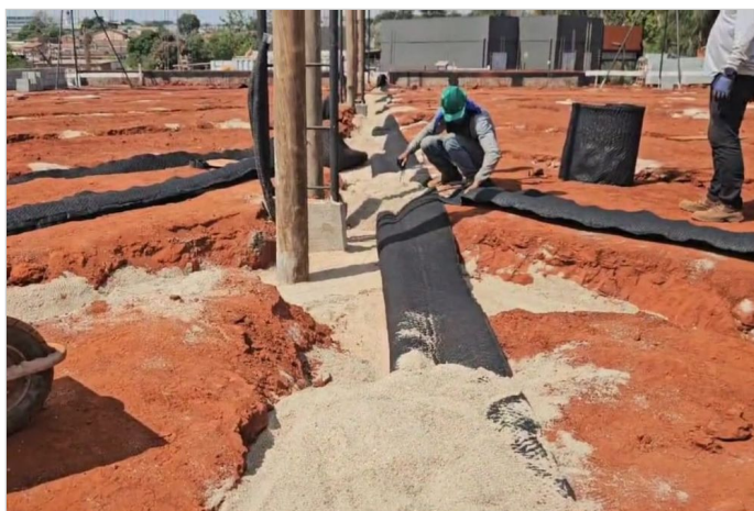
Durante a obra
