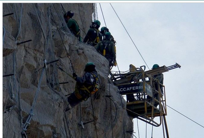
Durante la Obra
