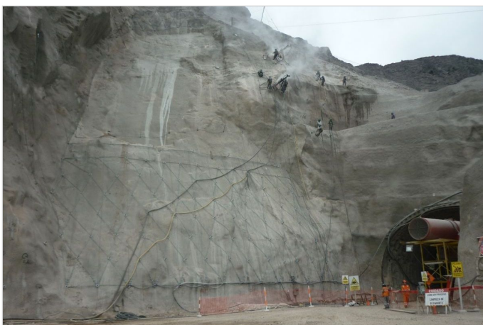
Durante la Obra
