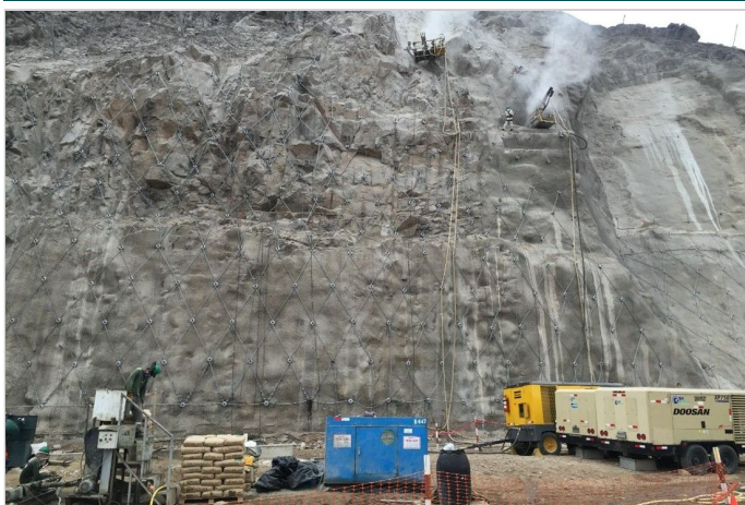
Durante la Obra
