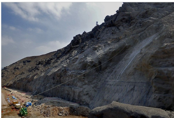
Durante la Obra
