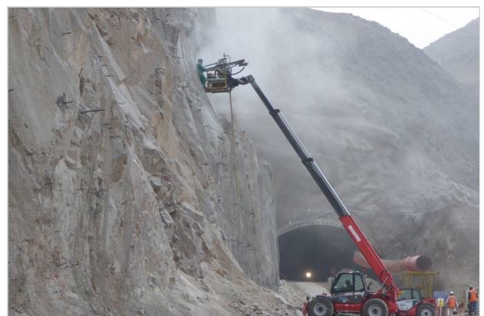
Durante la Obra
