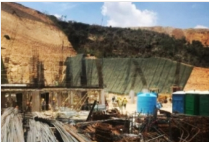
Durante la Obra
