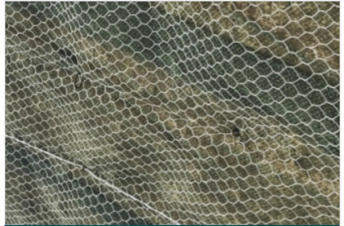
Durante la Obra
