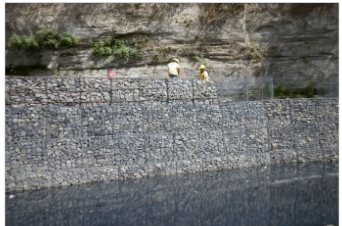
Durante a obra
