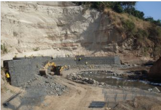
Durante a obra
