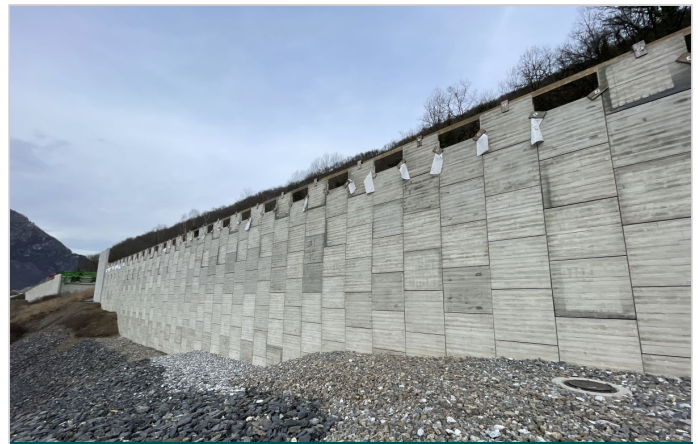
Ecailles du parement MacRes en cours de pose
