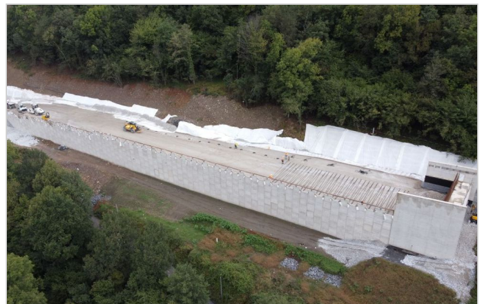
Vue d'ensemble du chantier ©Eiffage
