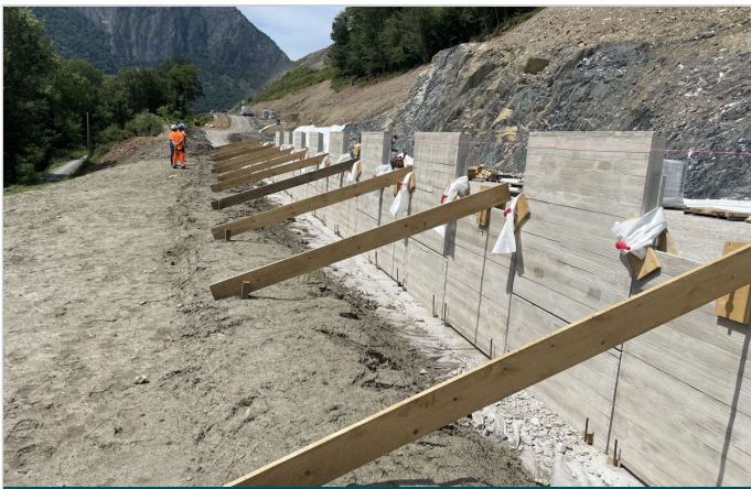
Parement MacRes en cours de pose
