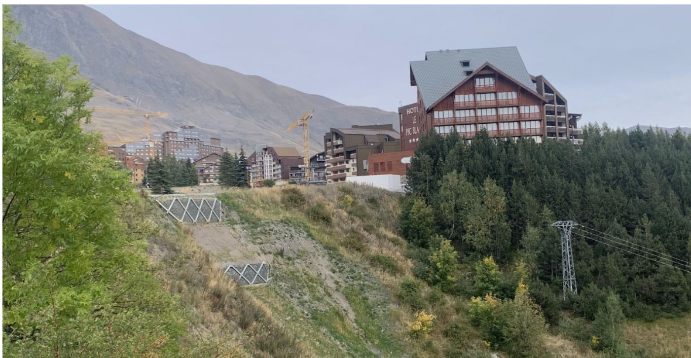
Vue d'ensemble du chantier
