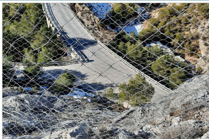
Detalle red de cable y malla secundaria de la barrera RB 750
