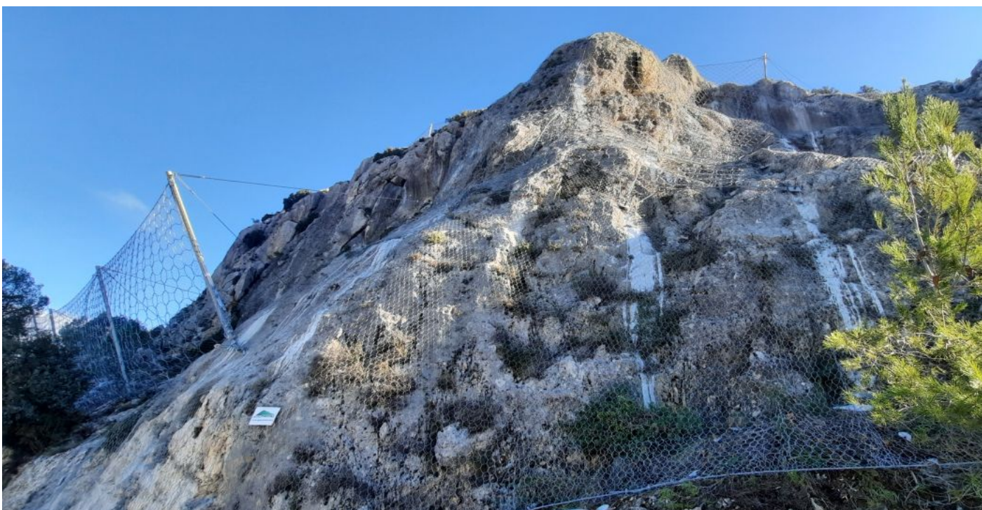
Vista general Barreras, Malla de Doble Trenzado 8x10-16 y red de anillos MacRing
