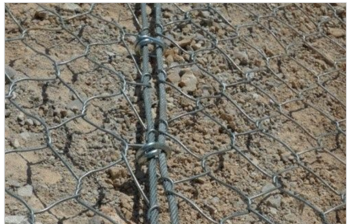
ΠΛΕΥΡΙΚΗ ΣΥΝΔΕΣΗ ΡΟΛΩΝ STEELGRID BO-300
