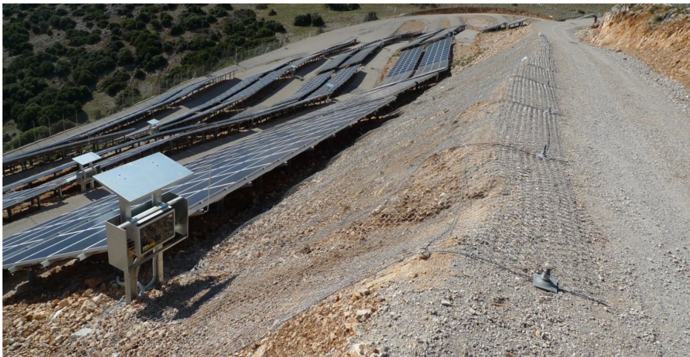
ΠΛΗΡΩΣ ΑΓΚΥΡΟΥΜΕΝΟ ΠΛΕΓΜΑ STEELGRID BO-300
