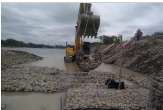
Durante la Obra
