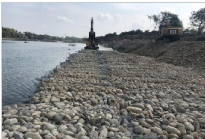
Durante la Obra
