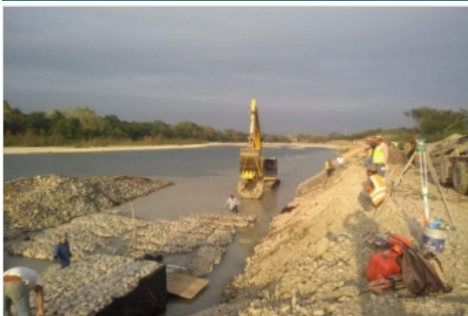
Durante la Obra
