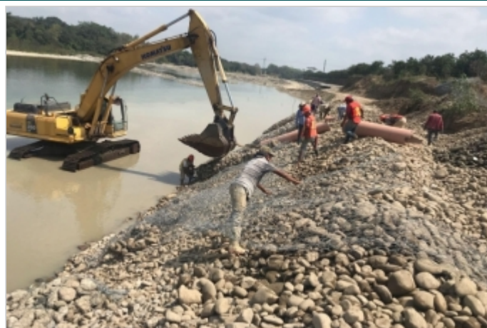
Durante la Obra
