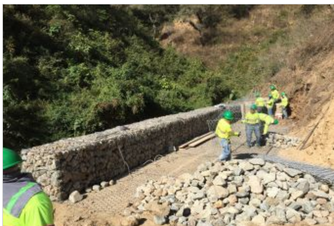
Durante a obra
