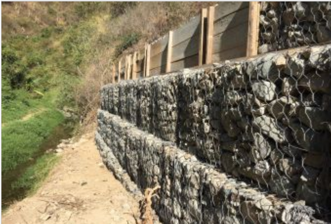
Durante a obra
