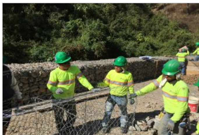
Durante a obra
