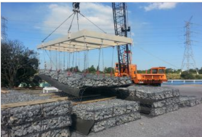
Durante a obra
