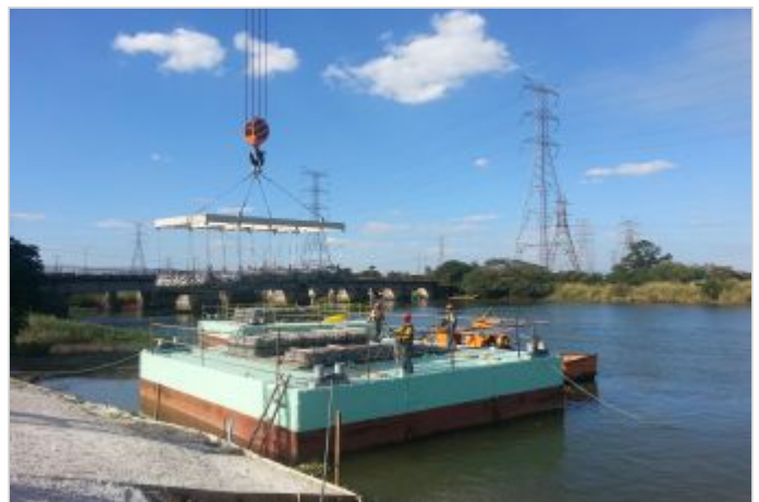
Durante a obra
