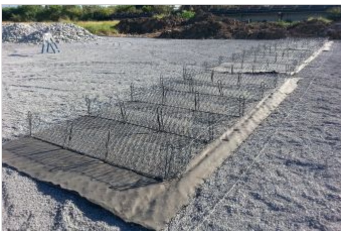
Durante a obra
