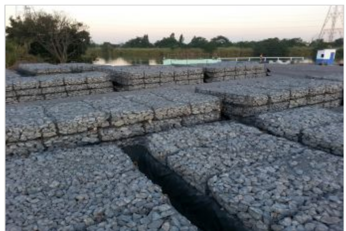
Durante a obra
