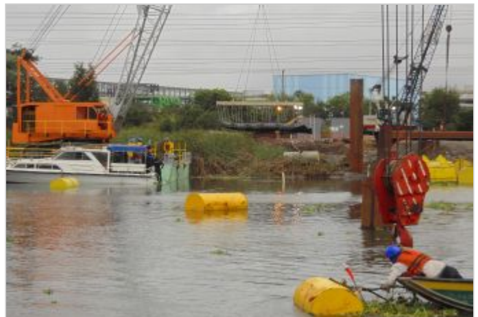
Durante a obra
