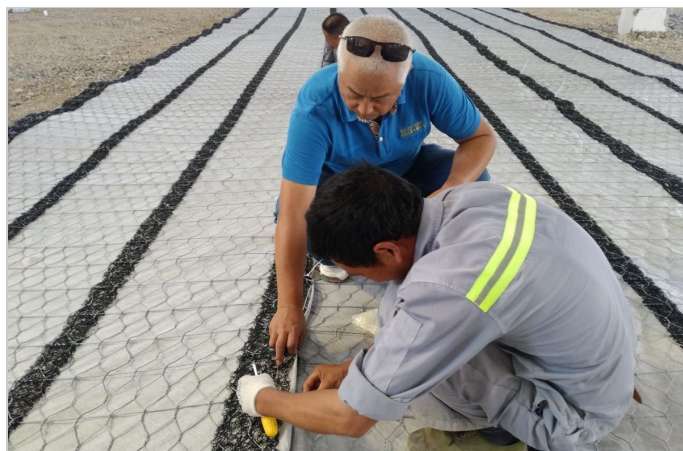
Flexmesh DT现场施工
