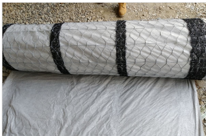
Flexmesh DT施工
