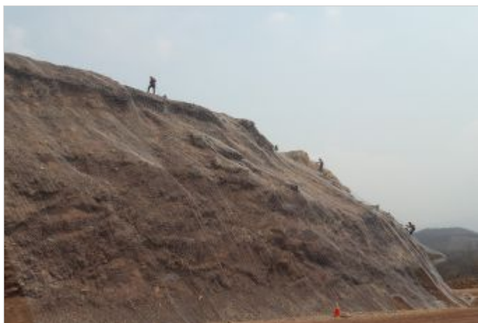
Durante a obra
