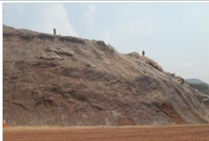
Durante a obra
