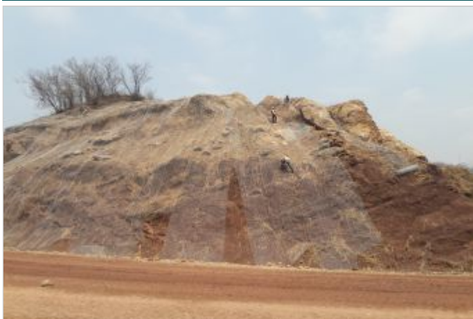
Durante a obra
