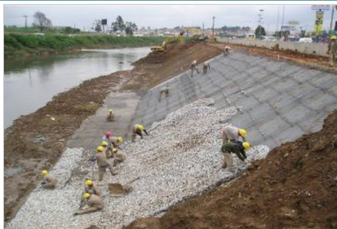
Durante a obra
