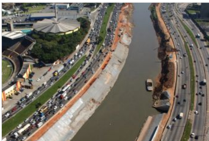
Durante a obra
