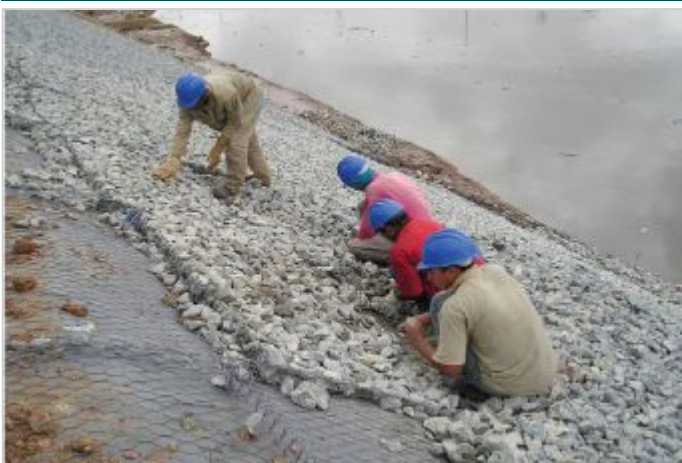
Durante a obra
