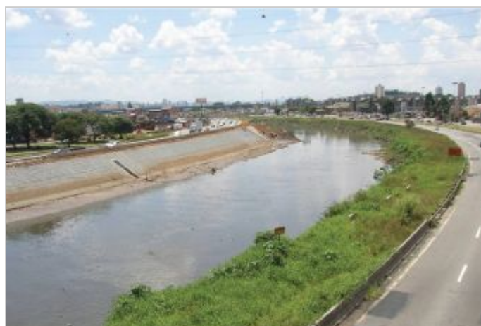
Durante a obra
