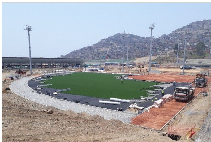
Durante la Obra
