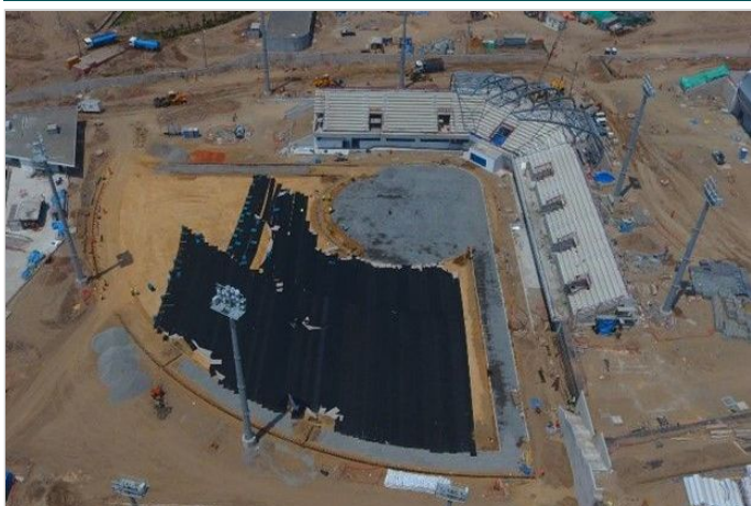
Durante la Obra
